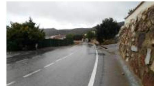
Detalle de la Carretera de Diputación en el entorno de la Barriada de Los Llanos. La propuesta de trazado de los colectores de aguas residuales será bajo la cuneta existente.
