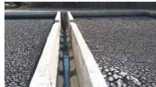
Eras de secado de la EDAR y detalle canal lixiviado.
